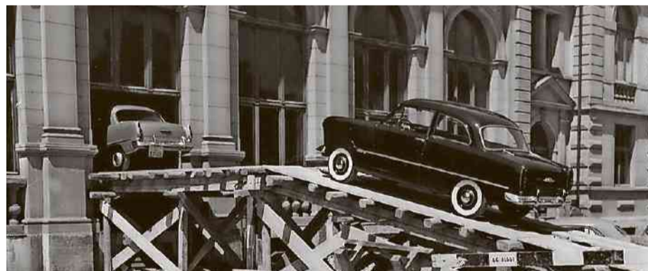
Auf einer provisorischen Holzrampe fahren zwei Ford-Taunus für die erste Auto-Ausstellung in den Konzertsaal. Die beiden Fensterposten mussten dafür durchgesägt werden.
