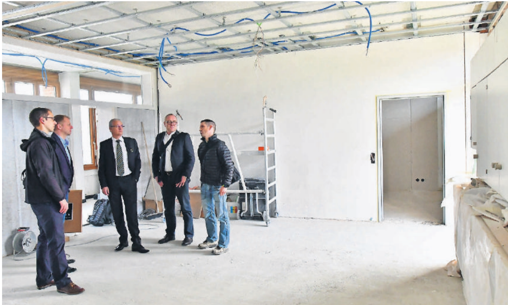
Das Schulhaus Jurablick in Kappel wird seit letztem Sommer saniert und soll noch vor den Sommerferien 2017 bezogen werden können. Von links Martin Schröder, Matthias Lorenz (beide Lorenz Architekten), Gemeindepräsident Rainer Schmidlin, Matthias Anderegg und Marcel Klaus (Bauleiter) nehmen ein neues Reserve-Klassenzimmer in Augenschein.
